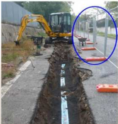
SCAVO A SEZIONE OBBLIGATA CON PROTEZIONI
