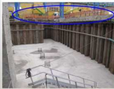
ARMATURA DELLO SCAVO CON PALANCOLE
