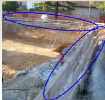
ARMATURA DELLO SCAVO CON PALANCOLE
